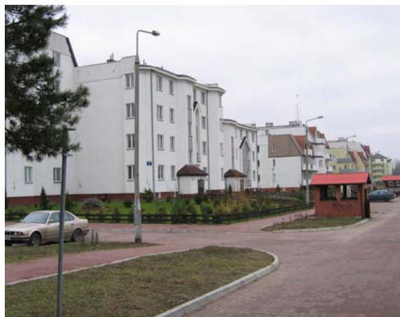
Fot. 17 Nowa zabudowa na osiedlu Piaski
