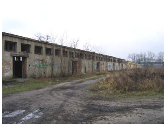
Fot. 22 Zdegradowana zabudowa dawnego Aviotexu
